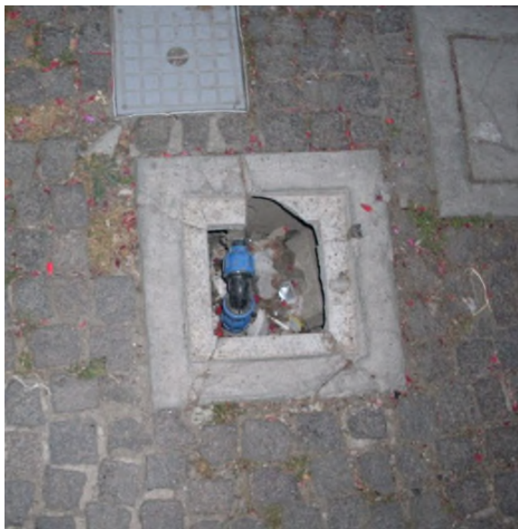
Figura 10 risanamento pozzetto ed eventuale allargamento
