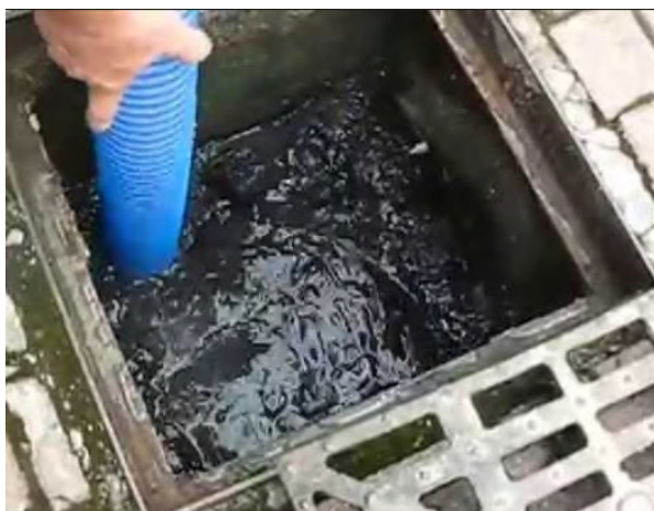
Figura 8 pulizia pozzetto con autospurgo
