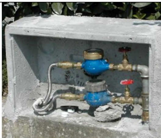
Figura 3 contatore in nicchia
