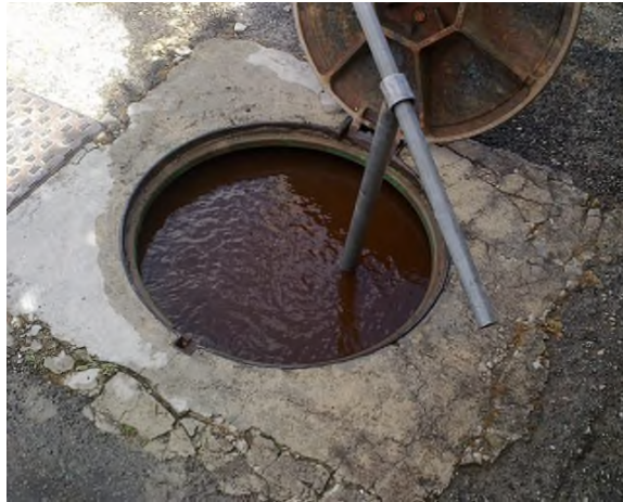
Figura 9 aggotamento acque con pompe sommerse
