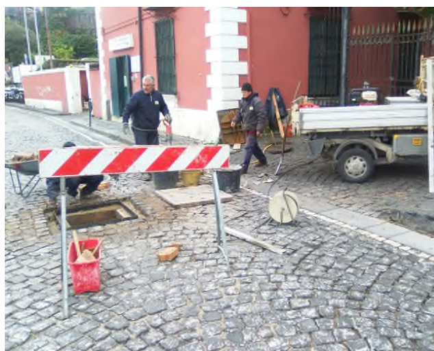
Segnali in testata cantiere
